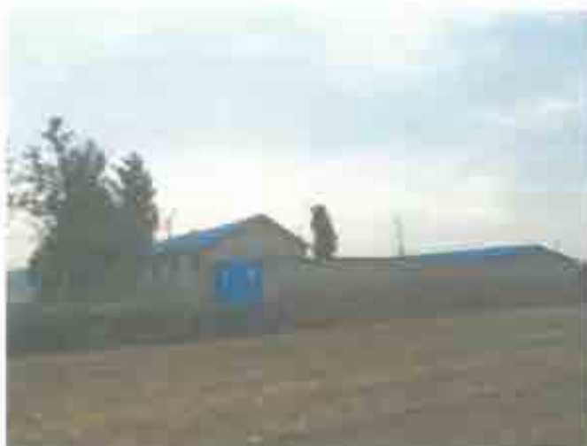
项目现场照片
