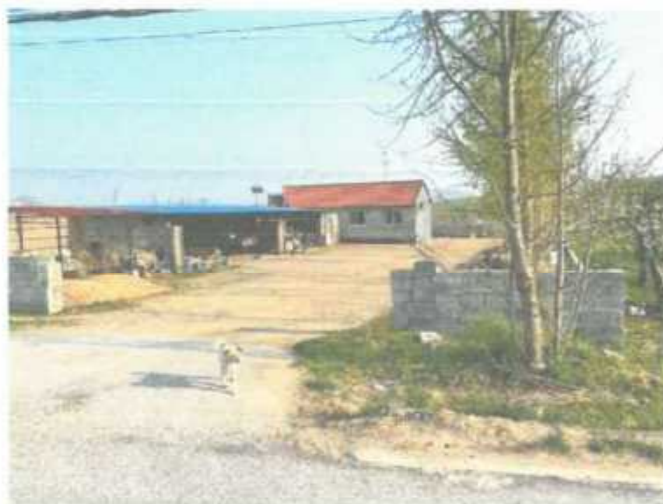
项目现场照片
