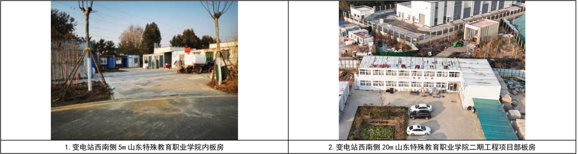
图 2-1 本工程环境敏感目标现场情况
