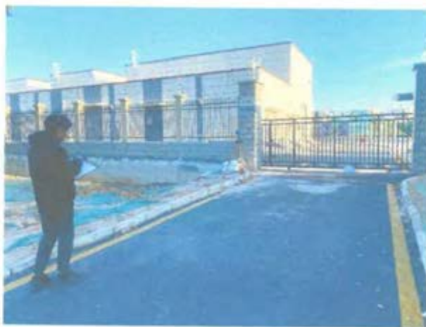
项目现场监测照片
