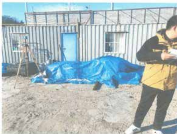
项目现场监测照片
