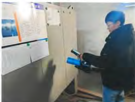
现场检测照片
