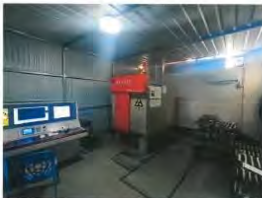
项目现场照片
