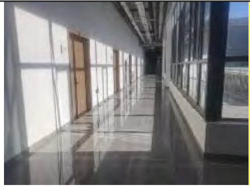
5号楼中试实验室楼上
