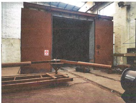
项目现场照片
