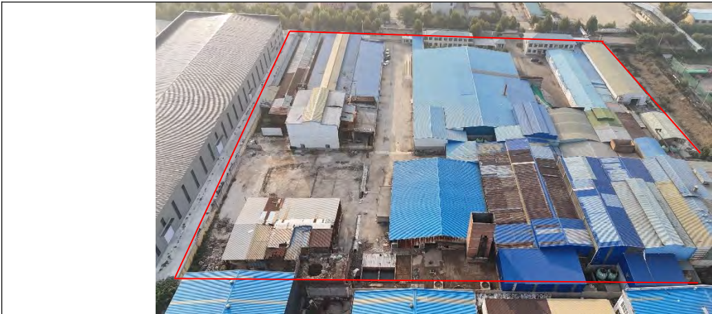
曝光室西侧 10m 邹平永强保温材料有限公司生产车间及配套用房
