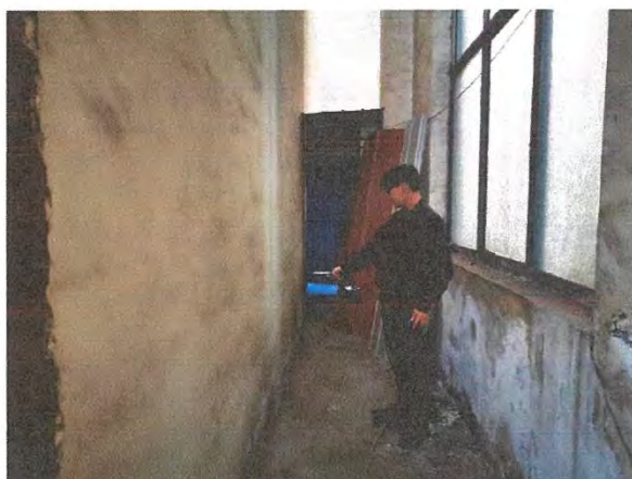
现场检测照片
