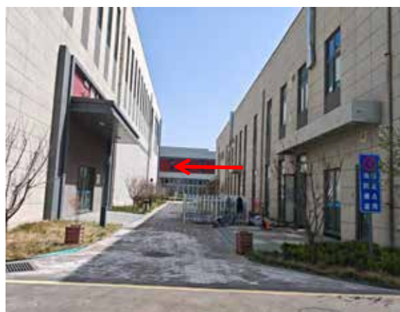
6号楼核医学实验大厅北侧院内道路、5号楼
