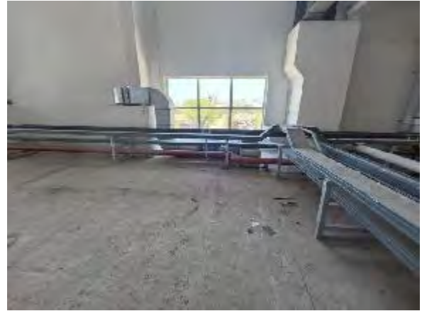
室顶、通风管道
