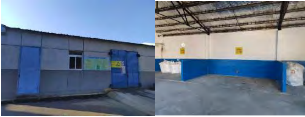
图 2-6 危废暂存间现场照片
