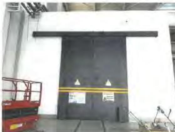
项目现场照片
