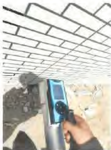
项目现场监测照片
