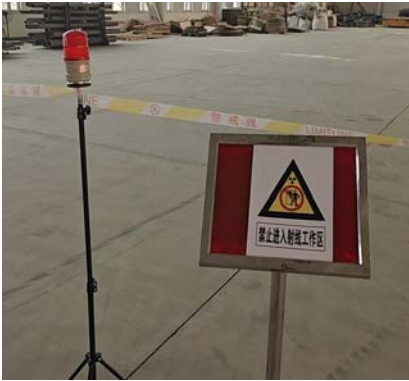
现场警示标牌、警示灯及警戒线
